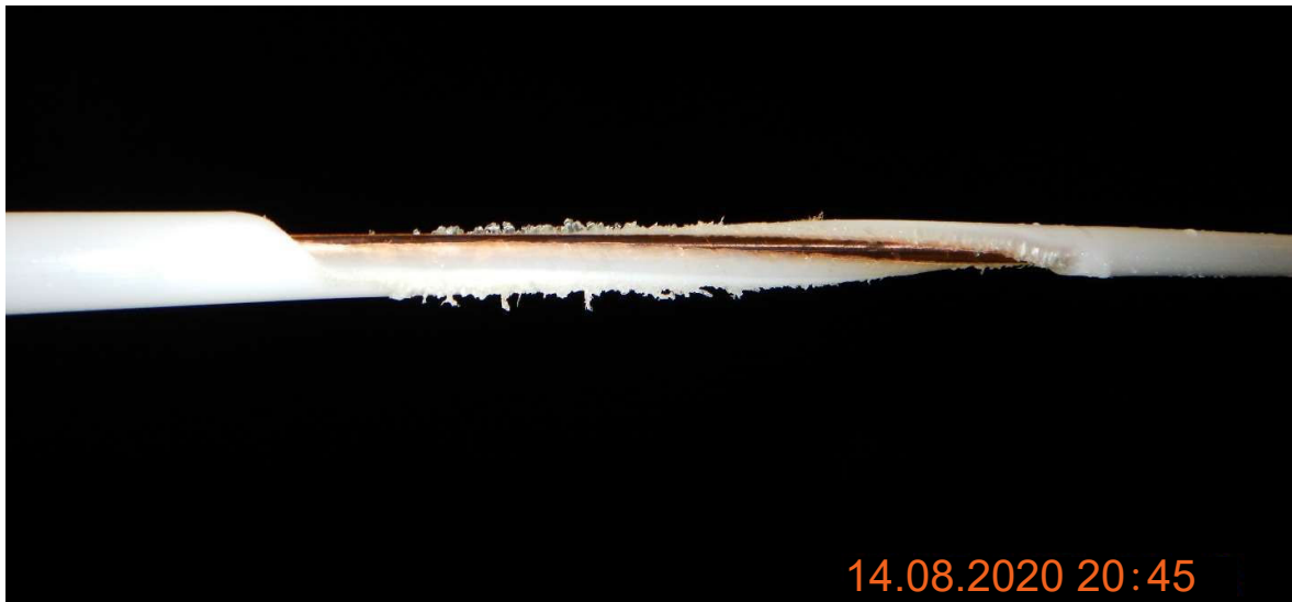
Figure 2 : Photographie d'un câble de faible poids endommagé par un enchevêtrement avec un amarrage des DCP près des Philippines, à 4 000 m de profondeur. Notez que l'isolation en polyéthylène a été dénudée par l'amarrage des DCP, exposant le conducteur en cuivre.
